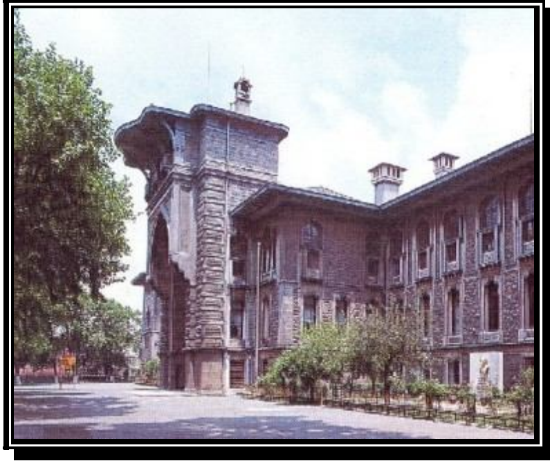
Resim 1.23: Alexandre Vallauray Deyun-u Umumiye Binası (Günümüzde İstanbul Erkek Lisesi)
